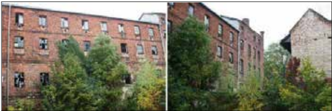
Die Reste von Pabst & Kilian hinter dem Haus Rathausstraße 21 in Raguhn im Jahr 2009 2
