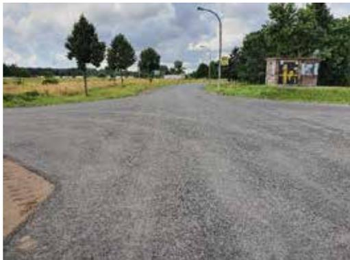
Im Abschnitt zwischen den Kreisen wurde bereits die verschlissene Deck- und Binderschicht gefräst und neu aufgetragen.
